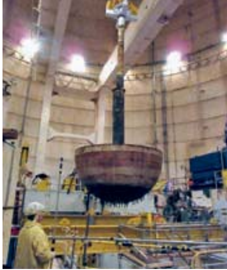
Ausheben der Kugelkalotte
