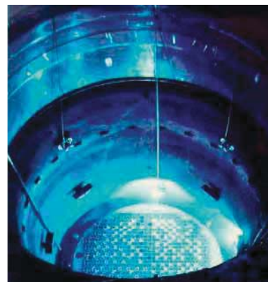
Oben: Geöffneter Reaktordruckbehälter mit Blick auf die Brennelemente des Reaktorkerns, daneben der Ausschnitt des 3D-Aktivierungsmodells. Ausschnitt: Der Kern ist die Quelle der Neutronen, die während des Reaktorbetriebs den Reaktorkern verlassen und Teile des Reaktorgebäudes aktivieren.
